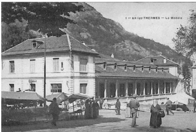
Fonds Teisseire. Etablissement du Modèle (démoli)
